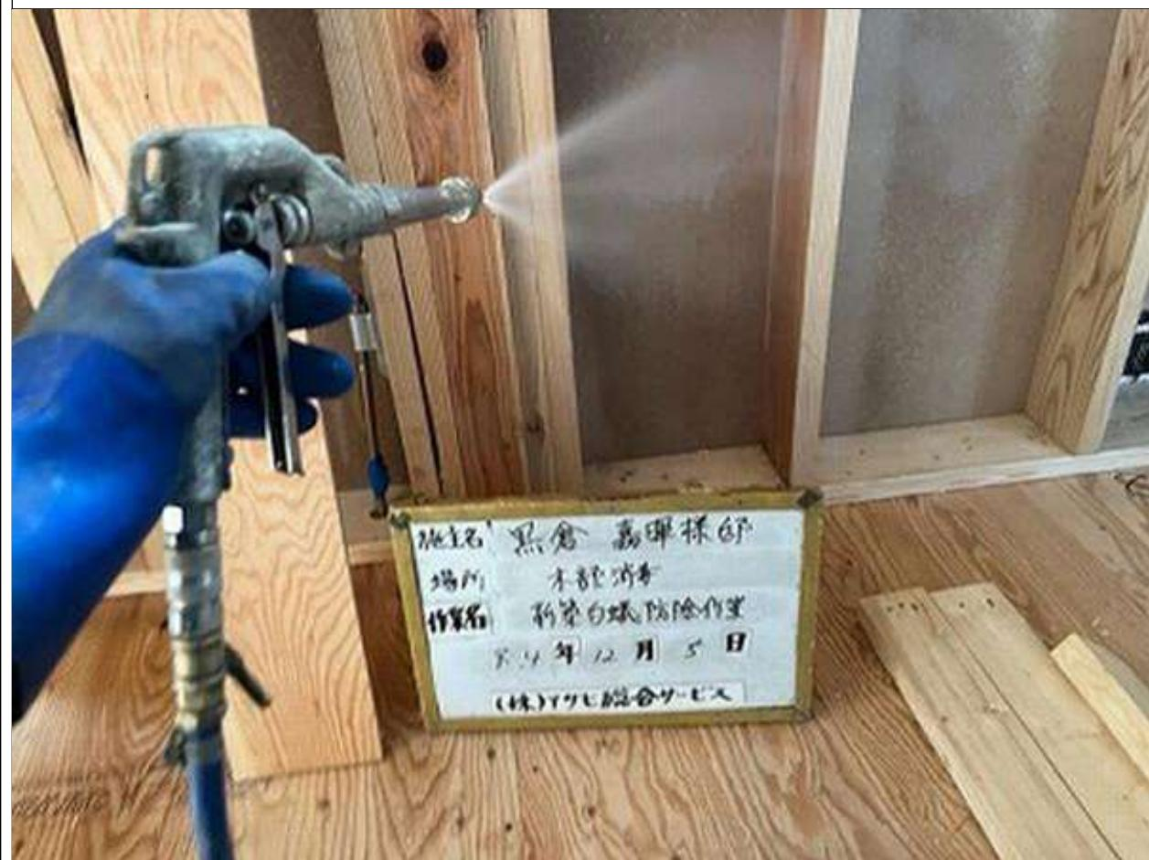
1-7 □地面からの高さが1m以内の外壁の枠組の防腐・防蟻措置を現場で塗布・吹付をする。(3/4)
