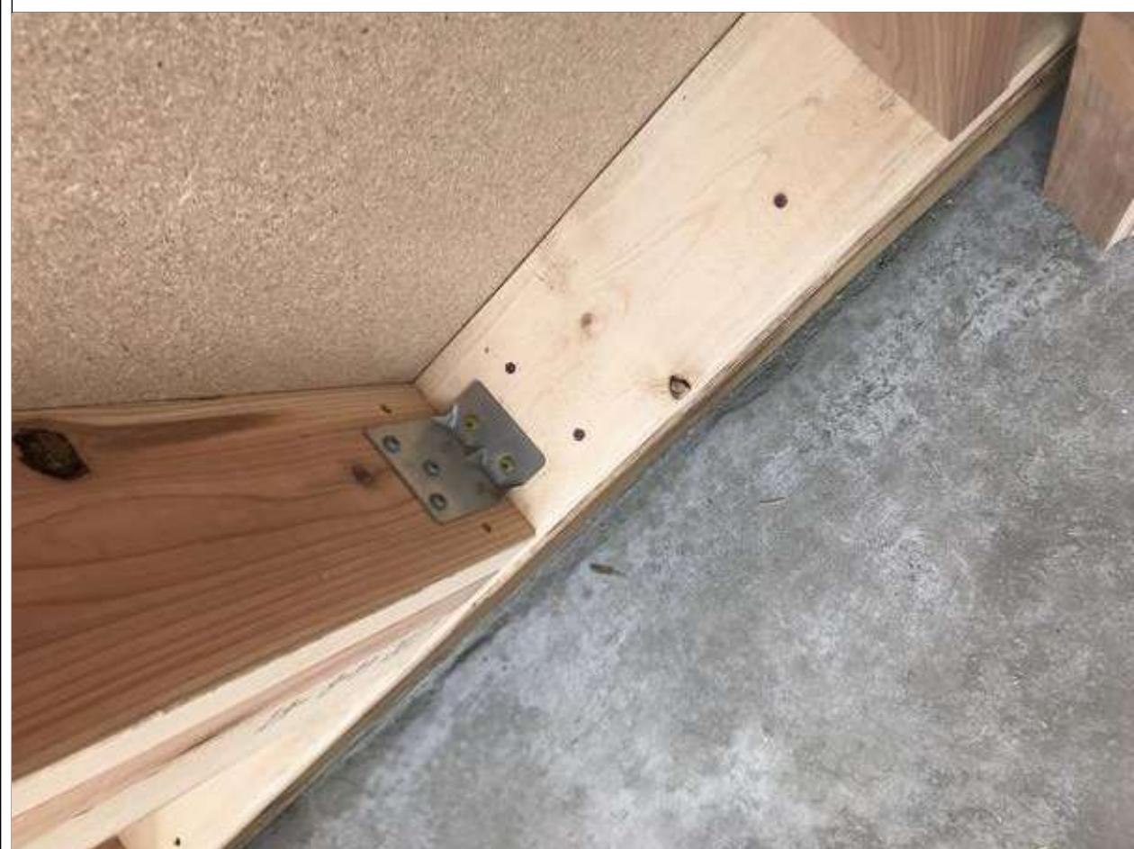
1-13□接合金物の種類・施工位置が図面通りか確認する。(3/3)
