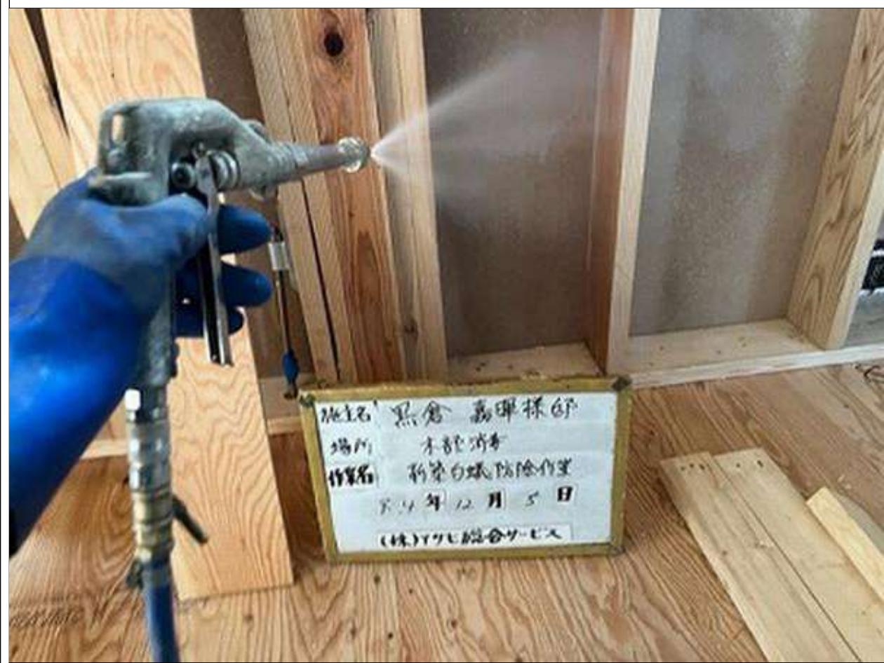
1-6□土台の防腐・防蟻処理材を用いる。(土台に接する外壁の下端には、水切りを設ける) (3/4)
