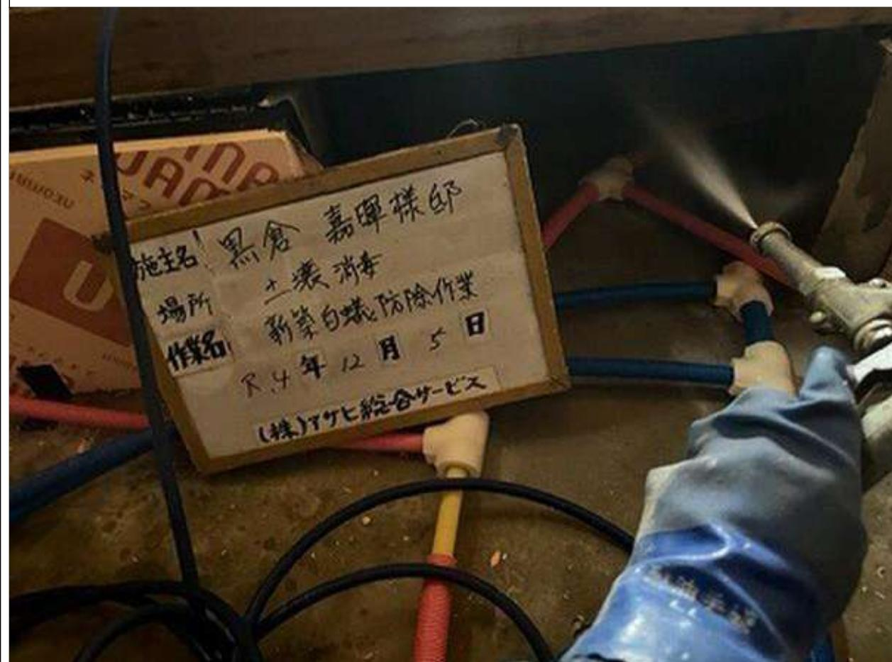
1-7□地面からの高さが1m以内の外壁の枠組の防腐・防蟻措置を現場で塗布・吹付をする。(4/4)
