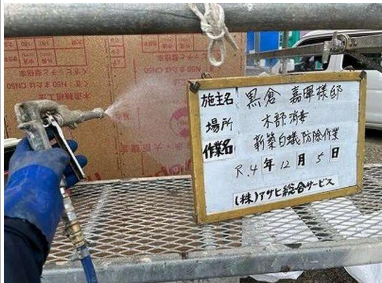
1-7 □地面からの高さが1m以内の外壁の枠組の防腐・防蟻措置を現場で塗布・吹付をする。(2/4)
