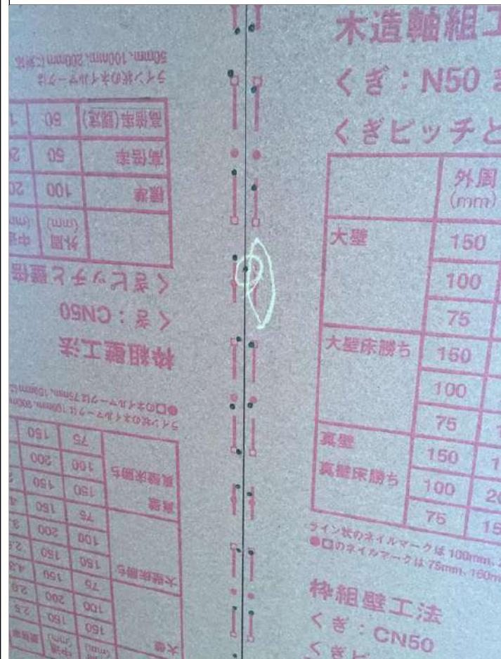
1-11 外壁下張りの釘のめり込み具合2mm以内か確認する。※デプスゲージにて沈み込みの確認。
