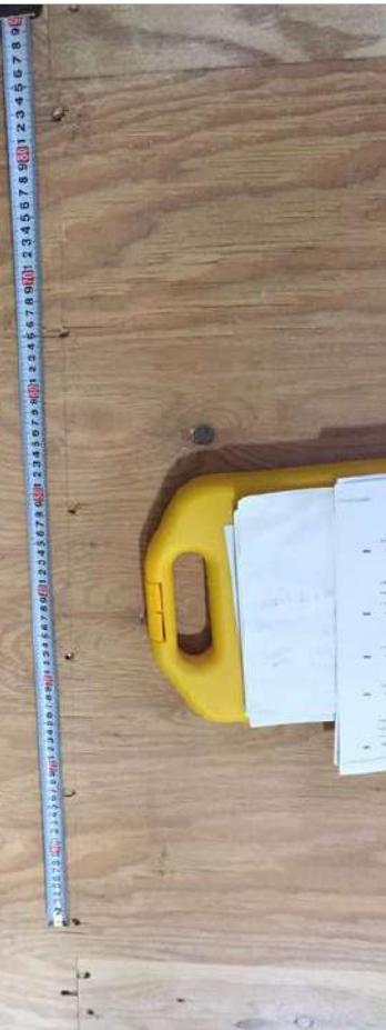
1-9□床下張材のくぎ打ちはCN50を周辺部150mm間隔以内、中間部200mm以内で平打ちする。床下張材の厚さが15mm以上の場合、CN65が望ましい。(2/2)
