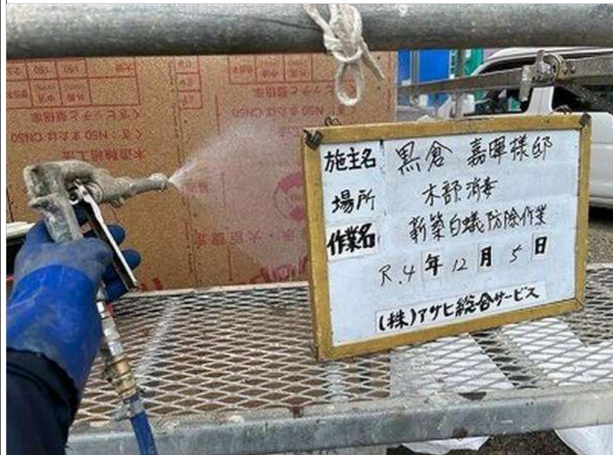
1-6□土台の防腐・防蟻処理材を用いる。(土台に接する外壁の下端には、水切りを設ける) (2/4)
