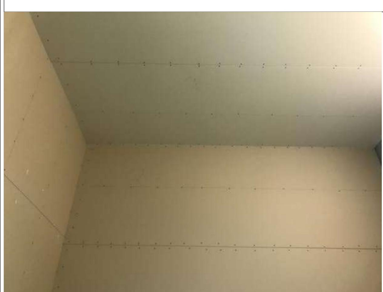
1-15 くぎ打ち間隔は外周100mm以内、中間部200mm以内の間隔で留め付ける。 (2枚張りの場合) くぎ打ち間隔は外周部及び中間部とも200mm以内とする。(1/2)
