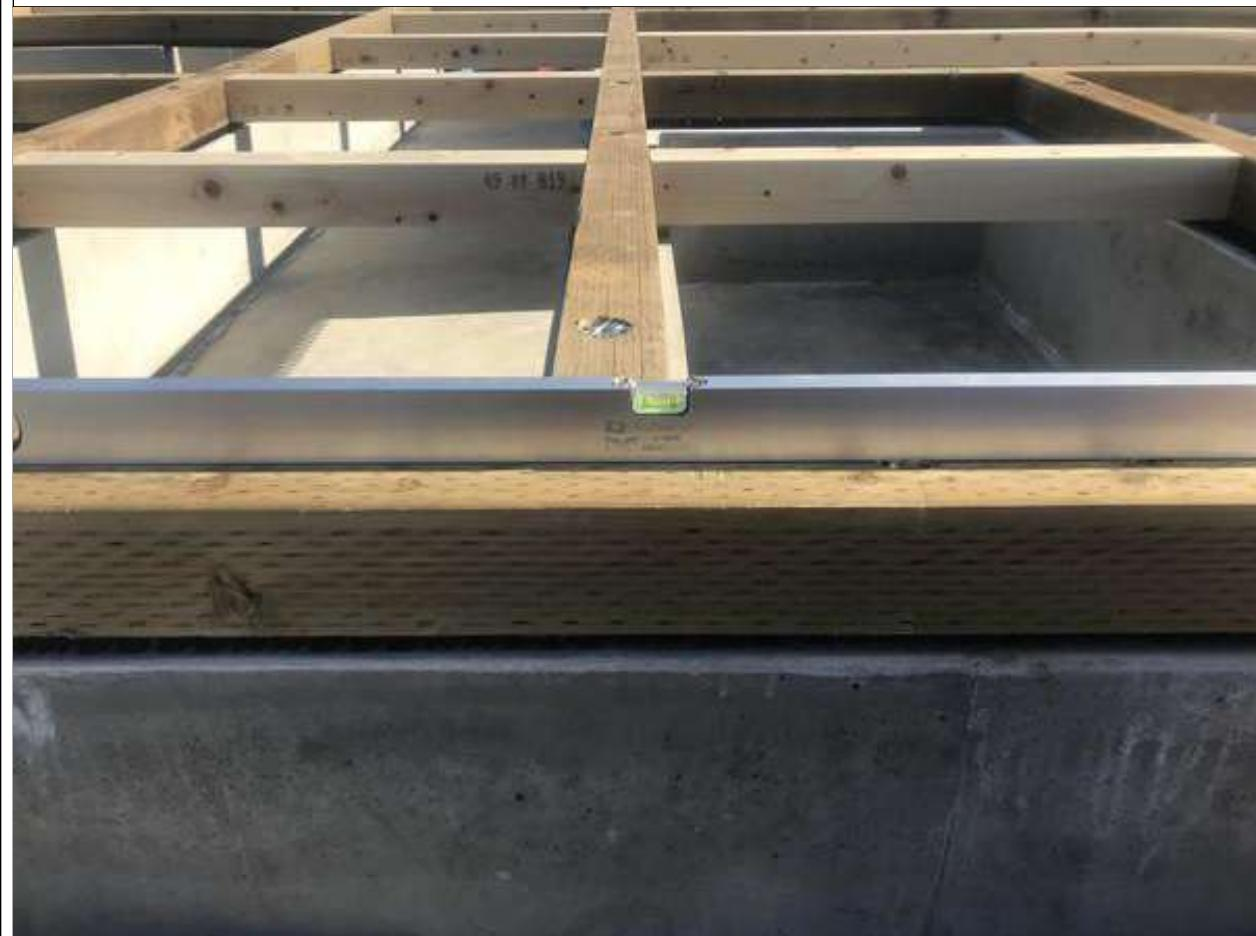
1-4□基礎パッキン・気密パッキン同士の隙間がないように敷き詰め、土台とパッキンの芯を一致させる。
