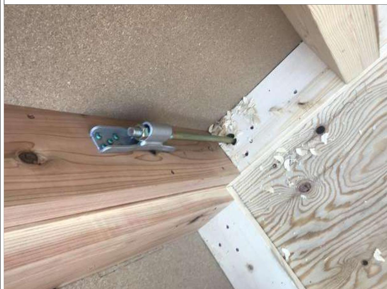
1-13□接合金物の種類・施工位置が図面通りか確認する。(2/3)
