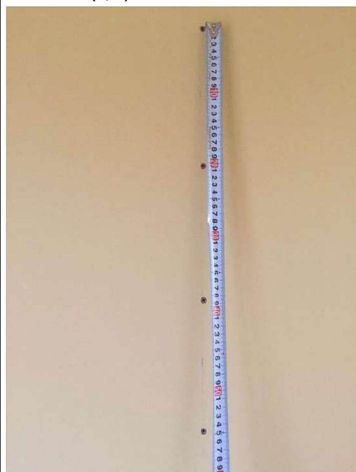
1-15 くぎ打ち間隔は外周100mm以内、中間部200mm以内の間隔で留め付ける。(2枚張りの場合) くぎ打ち間隔は外周部及び中間部とも200mm以内とする。(2/2)
