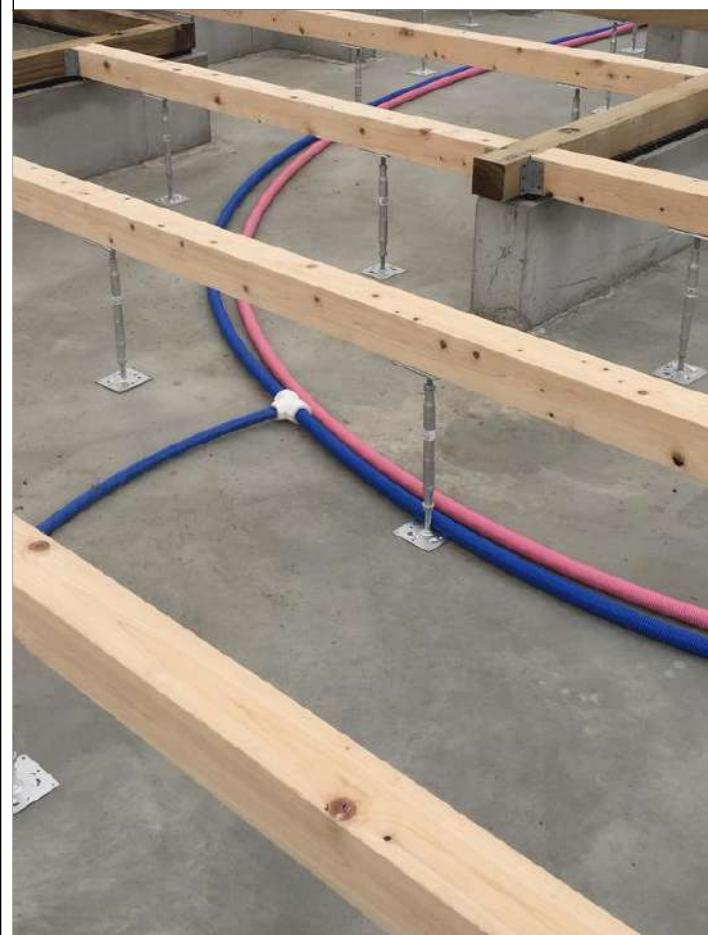
1-13 □接合金物の種類・施工位置が図面通りか確認する。(1/3)
