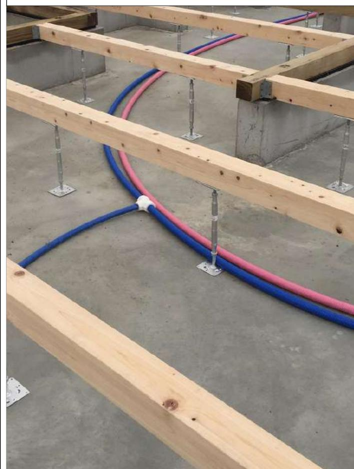
1-6□土台の防腐・防蟻処理材を用いる。(土台に接する外壁の下端には、水切りを設ける) (1/4)
