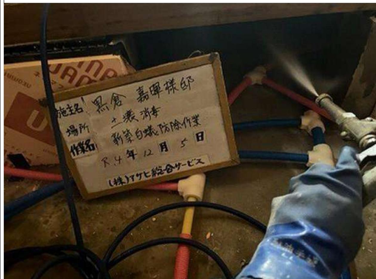
1-6□土台の防腐・防蟻処理材を用いる。(土台に接する外壁の下端には、水切りを設ける) (4/4)
