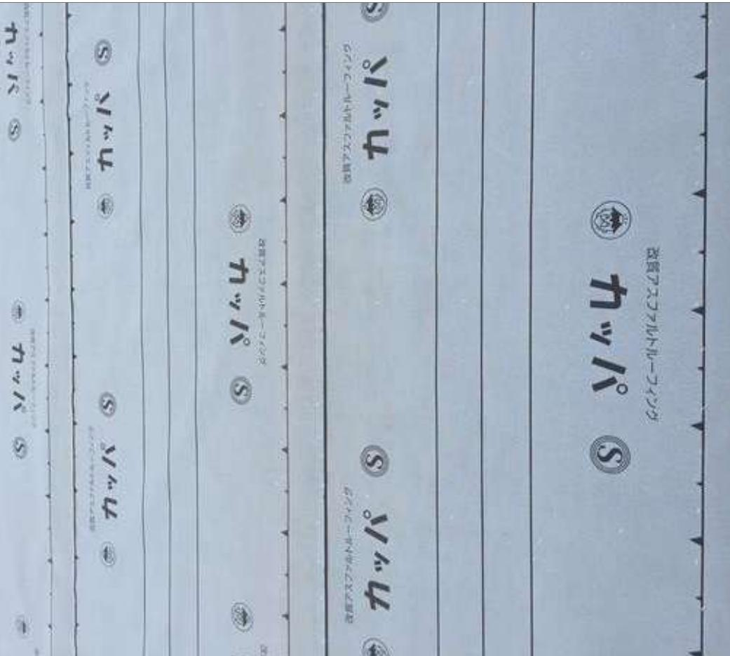
1-23 屋根ルーフィングの立ち上がり250mm以上確保し、上端は気密テープで圧着する。かつ雨押さえ上端より50mm以上とする
